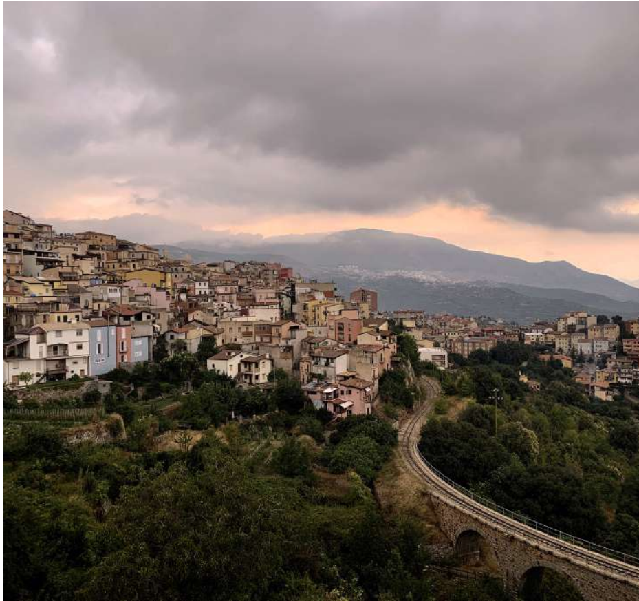
Scorcio di Lanusei e della ferrovia storica poco dopo l'arrivo in città
